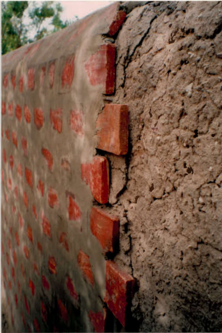
Revêtement d'un mur avec des briques cuites
