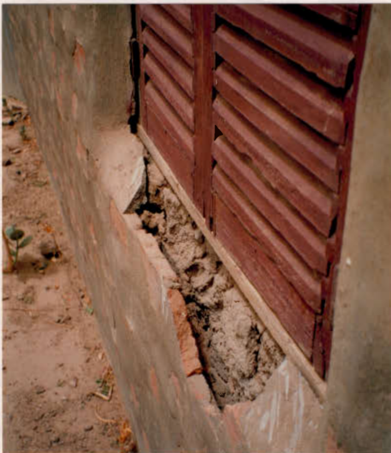
Mauvaise menuiserie; porte déscellée - Bâtiment 3 Revêtement en briques cuites, détaché du mur - Bâtiment 3.
