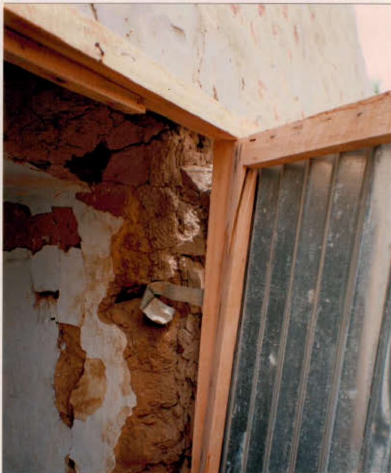
Mauvaise menuiserie; porte déscellée - Bâtiment 3 Revêtement en briques cuites, détaché du mur - Bâtiment 3.
